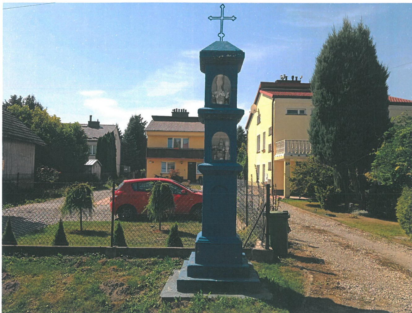
Widok na północno-wschodnią ścianę kapliczki
